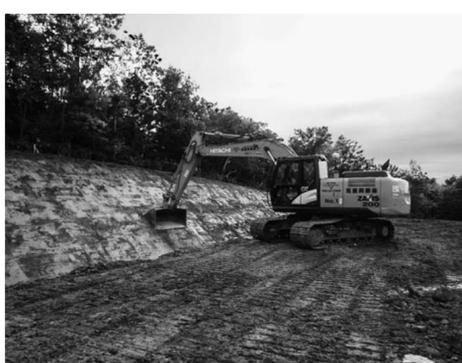
マシンガイダンスバックホウを使用した掘削工
